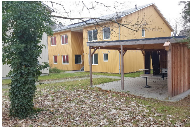
Gebäude der Studierendenwohnanlage Neuwiedenthal © Studierendenwerk Hamburg
