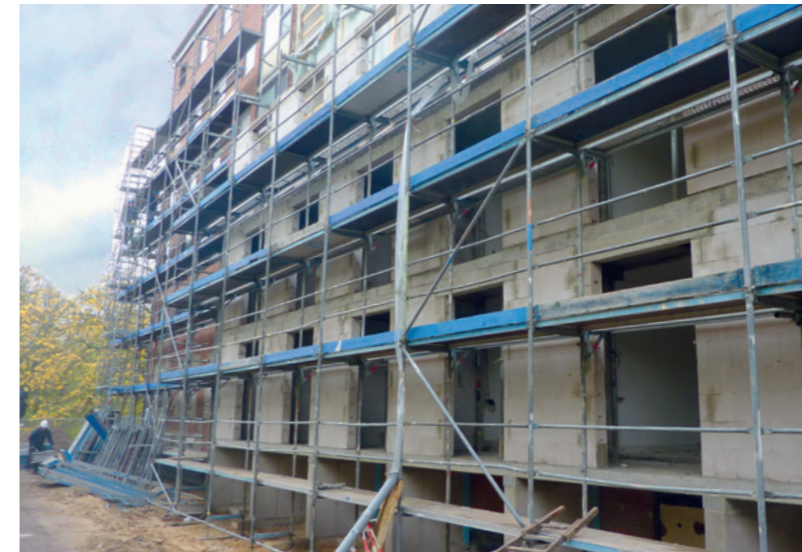
Für die Vergrößerung der Zimmer wird die Fassade des Rudolf-Laun-Hauses versetzt.
