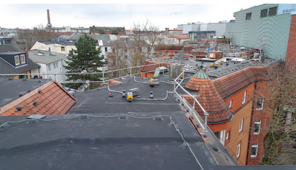
Über den Dächern von Harburg – Vor Baumaßnahmen am Dach der Wohnanlage Harburg galt es ebenfalls sichere Arbeitsbedingungen zu prüfen
