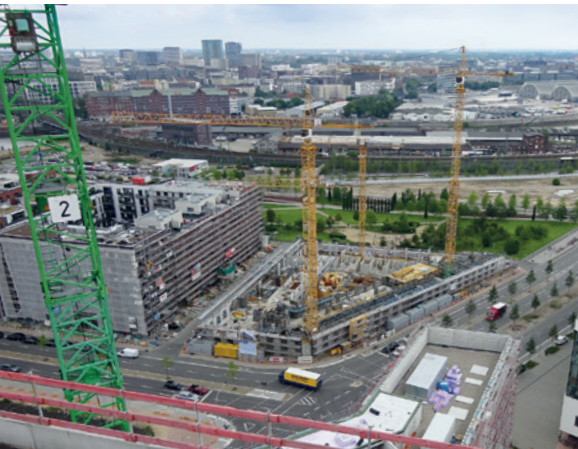
Baustelle des Helmut-Schmidt-Studierendenhauses mitten in der Hafencity
