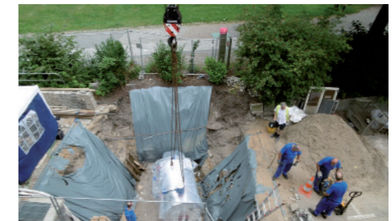
1 | Bauarbeiten am Studierendenhaus – Einbau der neuen Dampfesselanlage
