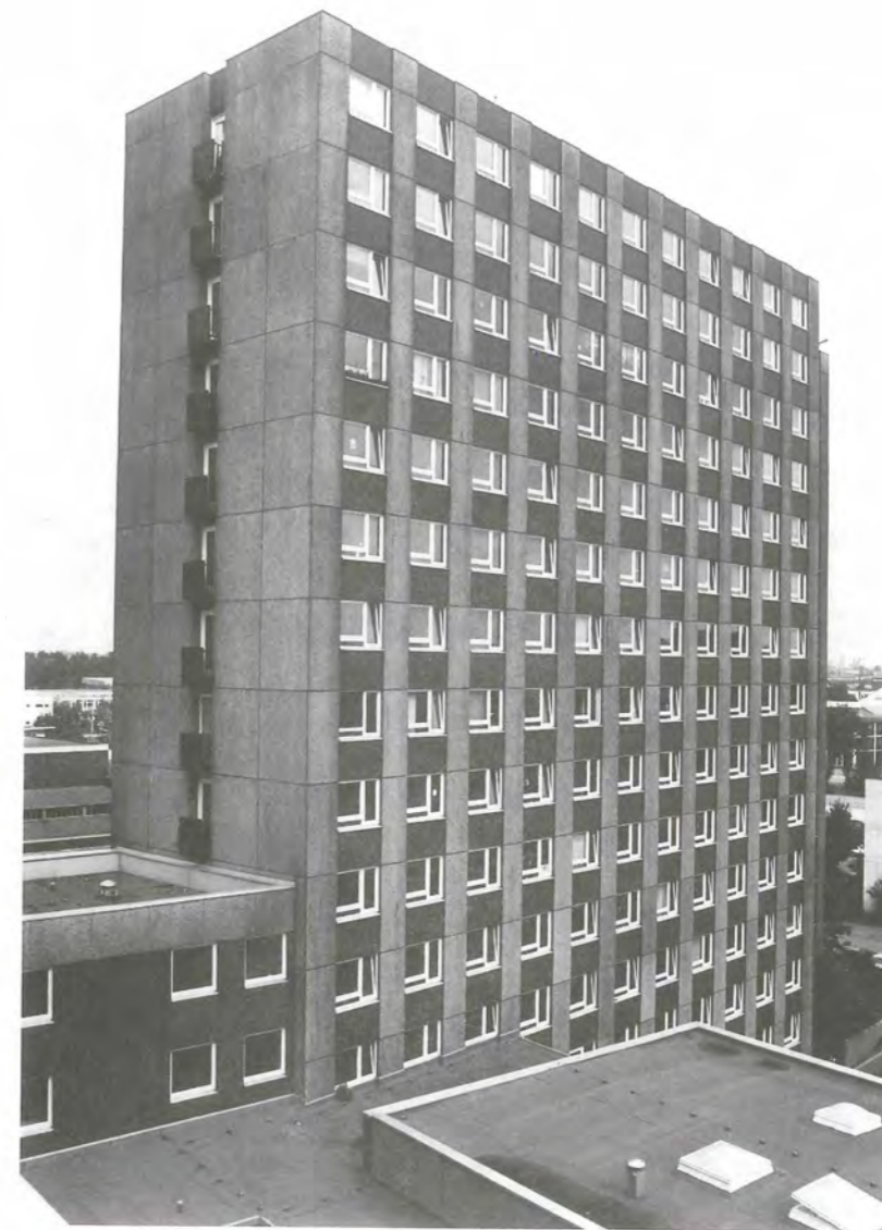
Wohnanlage Gustav-Radbruch-Haus; 476 Plätze; Baujahr 1969; Sanierung 1983:
