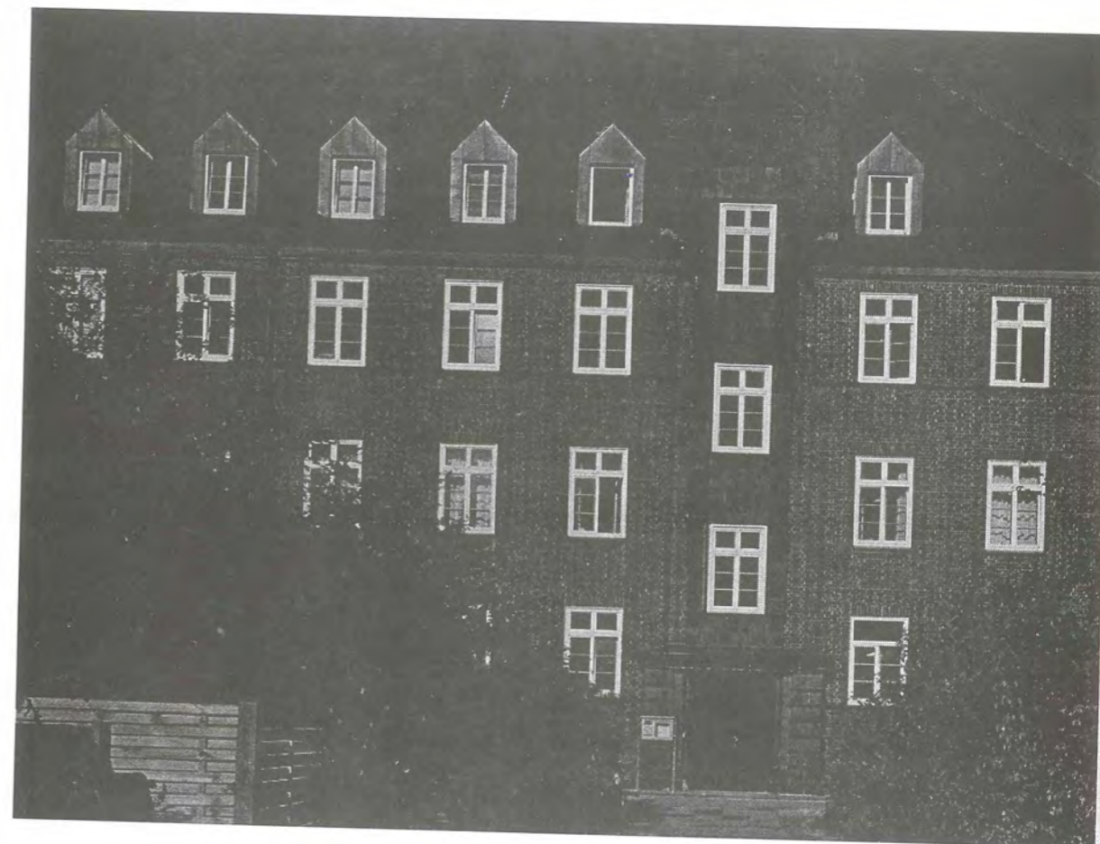
Wohnanlage Rahlstedt; Umwandlung eines Kasernengebäudes; Sanierung 1995; 136 Plätze.
